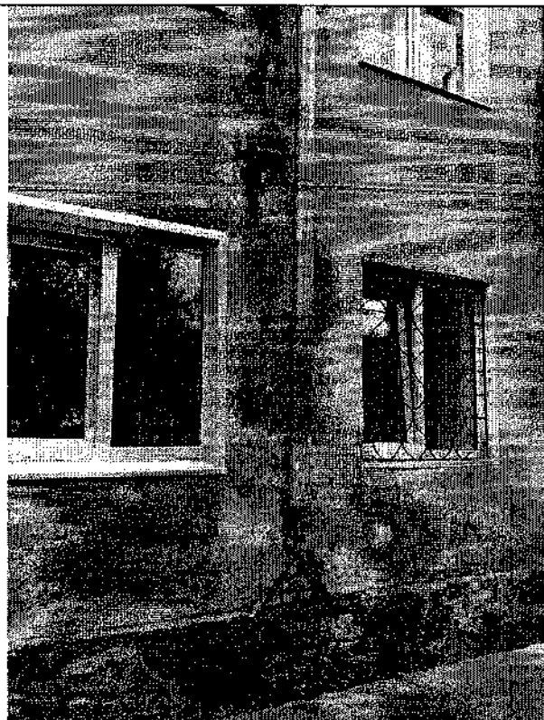
Фото 15, 16, 17, 18. Локальные участки разрушения асфальтобетонной отмостки, отхождение отмостки от стен здания, следов растительности, проседания, неплотного примыкания отмостки к цоколю, что способствует замачиванию фундамента здания, а также подвального помещения и не соответствует требованиям п. 6.26 СП 82.13330.2016 «Благоустройство территорий».
